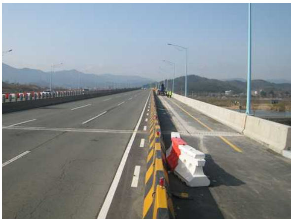
2024년 상부 범물방향 합류부 방호벽 제거구간 현황
