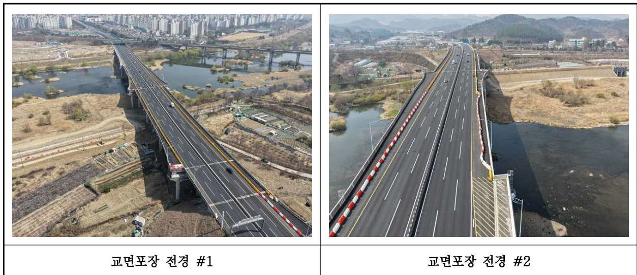
【사진 1.3.19】 교면포장 전경
