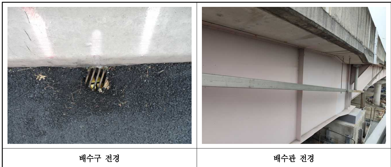
【사진 1.3.48】 배수시설 전경
