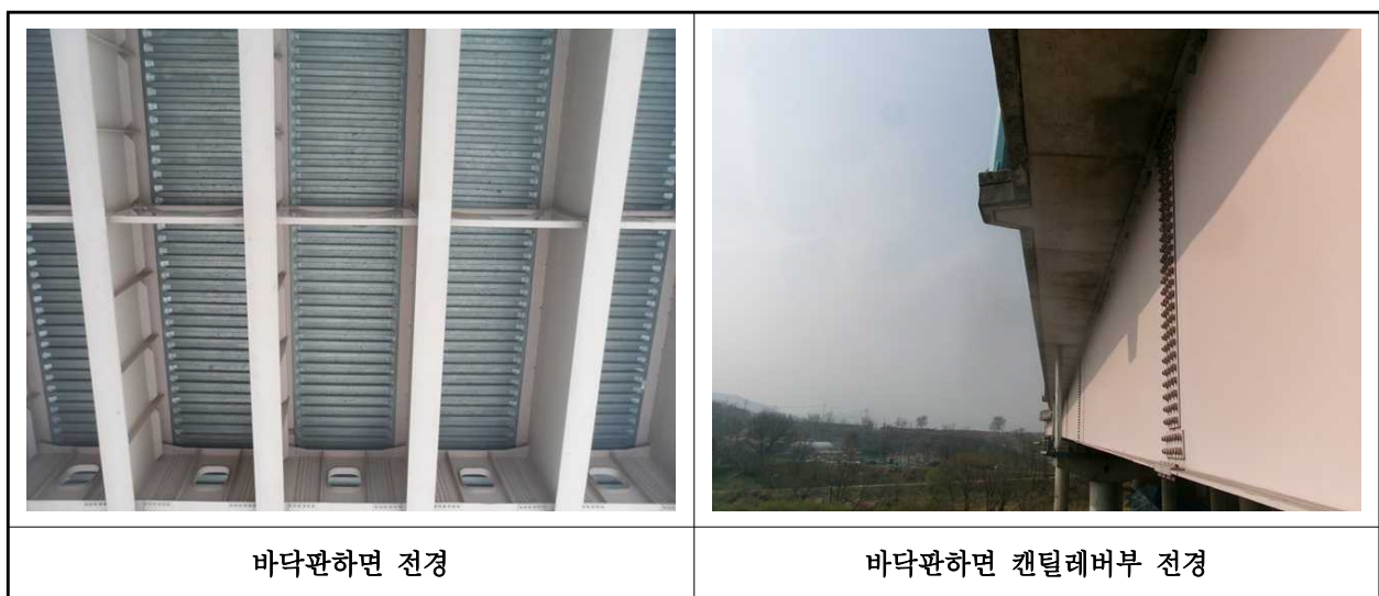
【사진 1.3.28】 바닥판하면 전경
