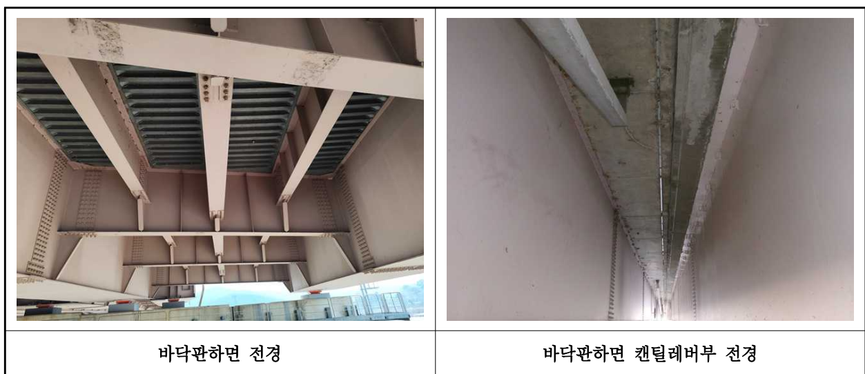
【사진 1.3.2】 바닥판하면 전경
