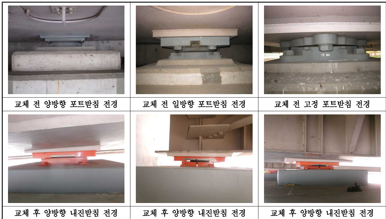
【사진 1.3.12】 교량받침 전경
