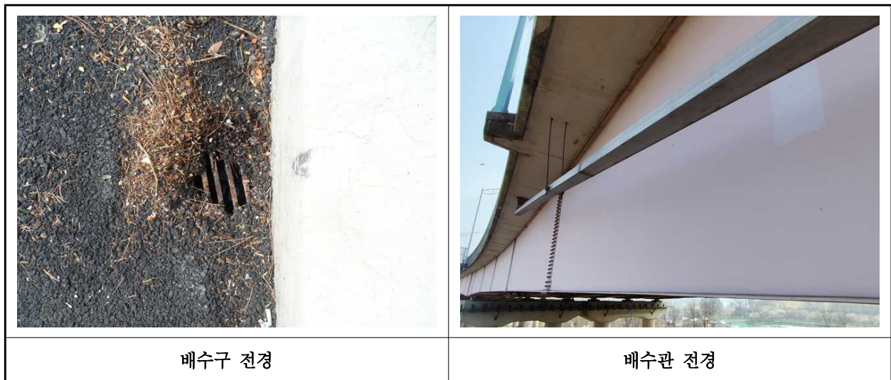
【사진 1.3.21】 배수시설 전경
