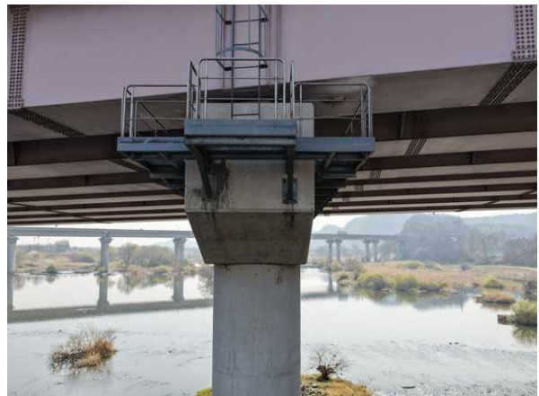
교각 P6 코핑부 상태현황
