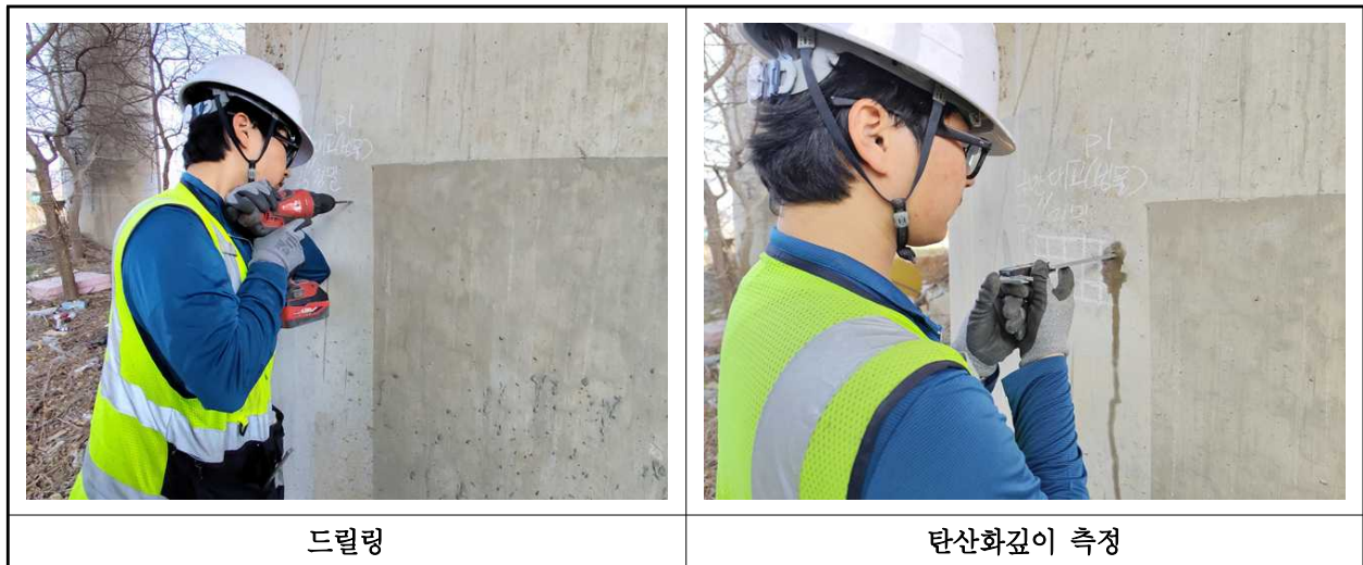
【사진 1.4.3】 탄산화 깊이 측정 현장사진
