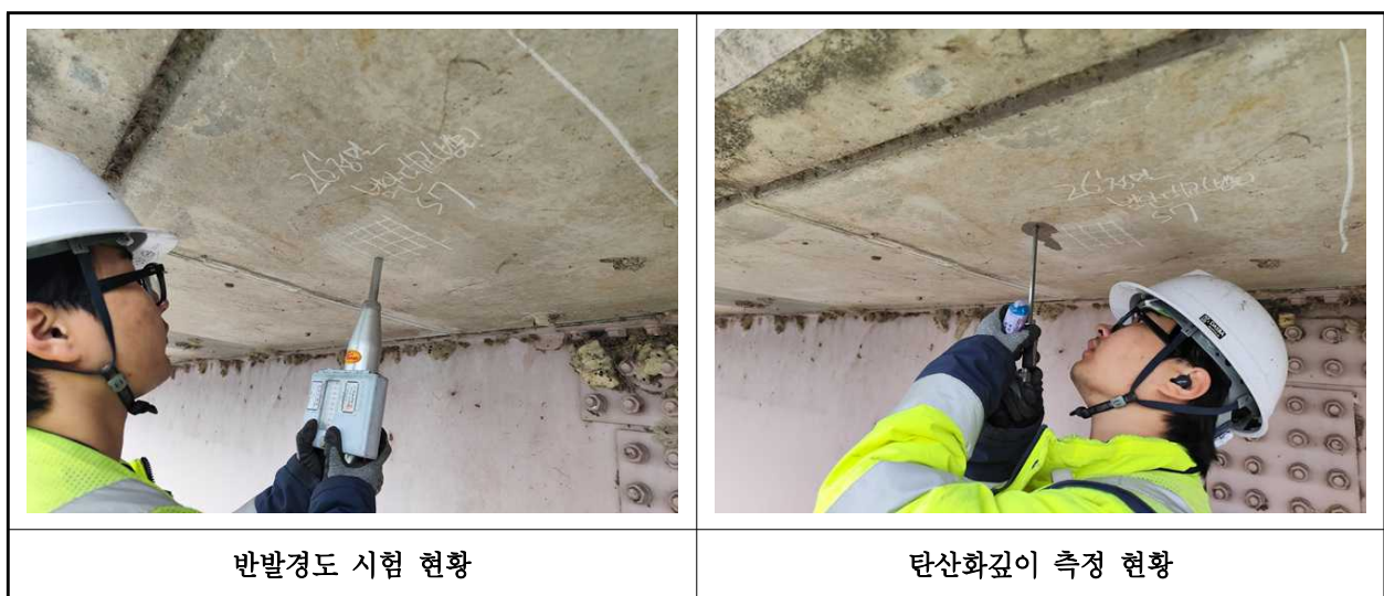
【사진 1.4.1】 콘크리트 내구성조사 현황
