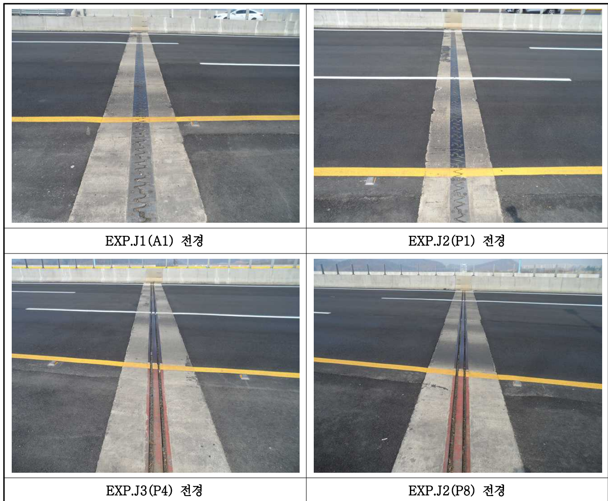
【사진 1.3.43】 신축이음장치 전경
