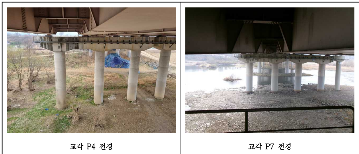
【사진 1.3.36】 교각 전경
