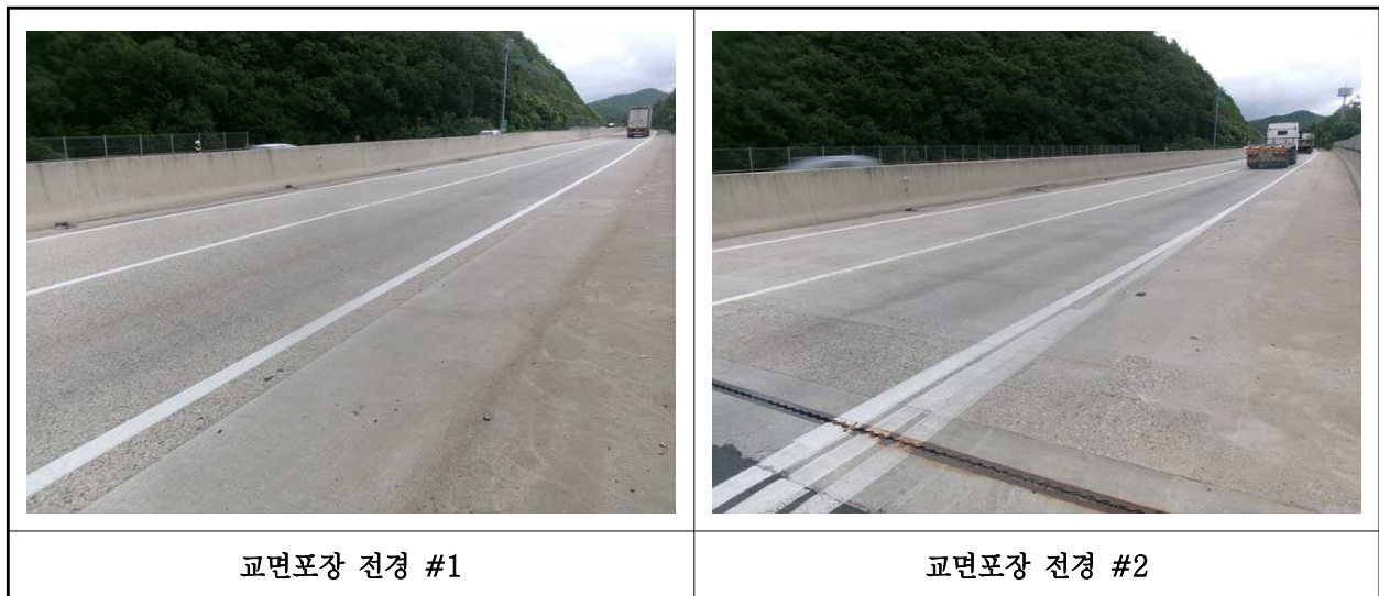
【사진 1.3.46】 교면포장 전경
