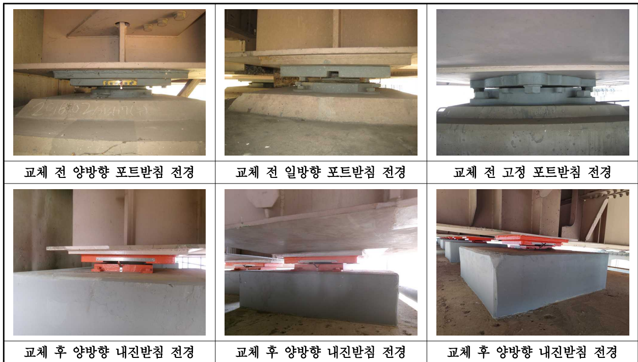
【사진 1.3.39】 교량받침 전경
