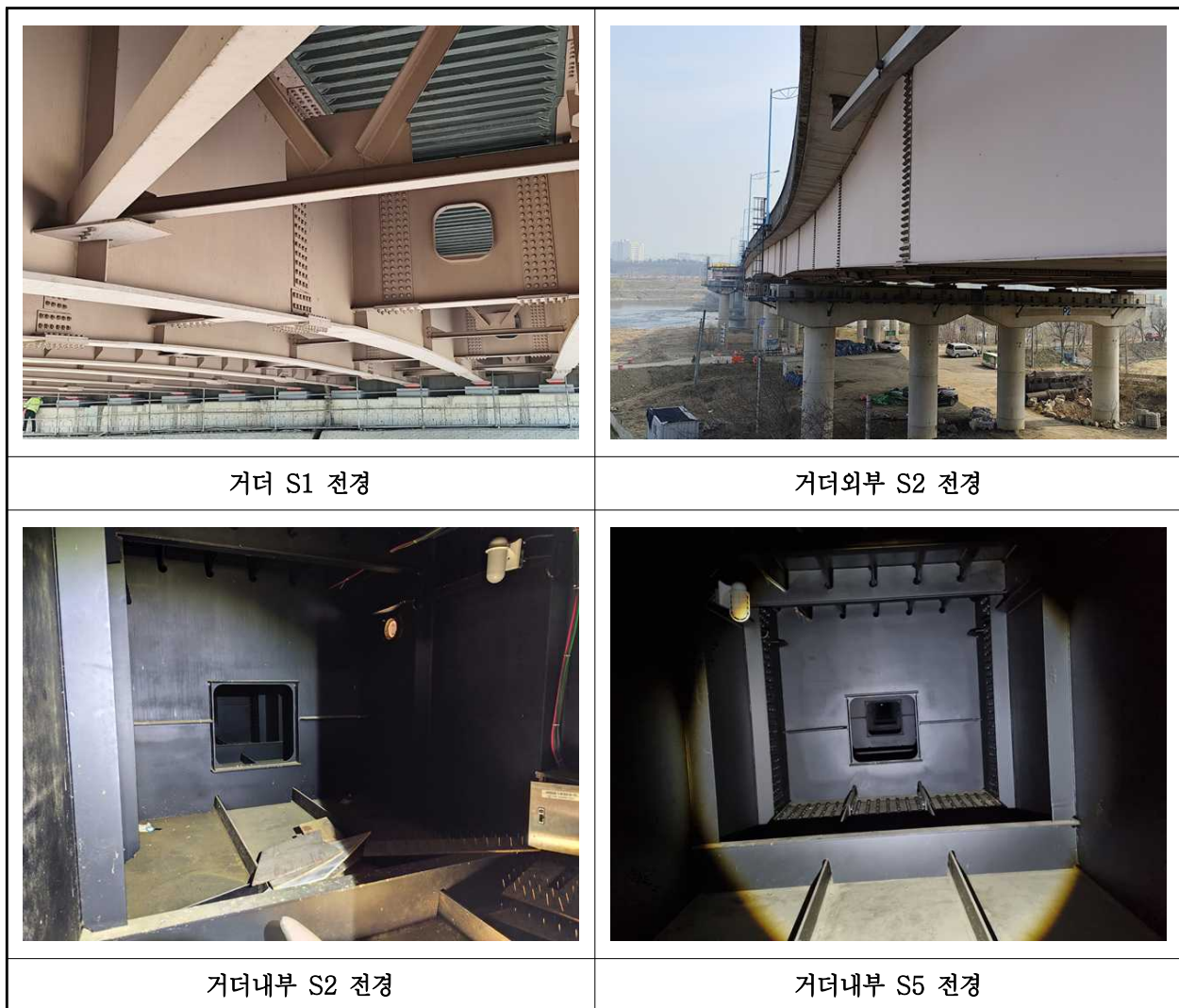
【사진 1.3.4】 거더 전경
