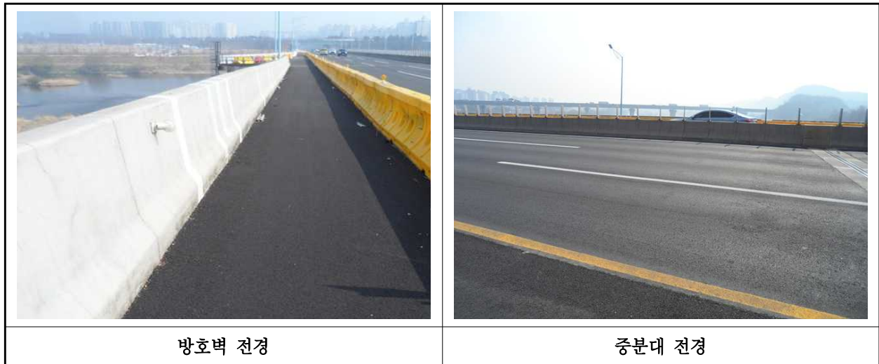
【사진 1.3.23】 방호벽 및 중분대 전경
