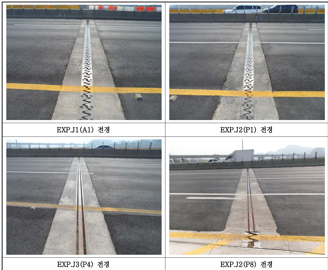
【사진 1.3.16】 신축이음장치 전경
