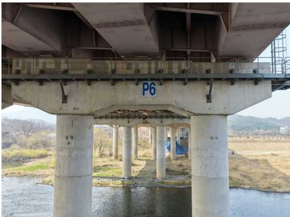
교각 P6 코핑부 상태현황
