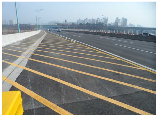
2026년 상부 범물방향 합류부 방호벽 제거구간 현황
