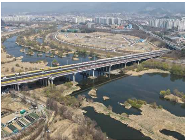
하부 교차 시설(금호강, 금호강변로) 전경
