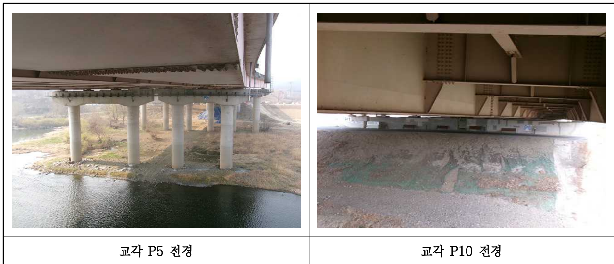
【사진 1.3.10】 교각 전경
