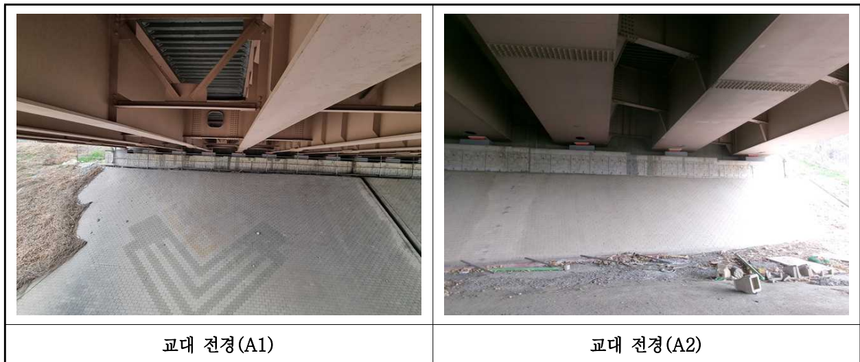
【사진 1.3.34】 교대 전경
