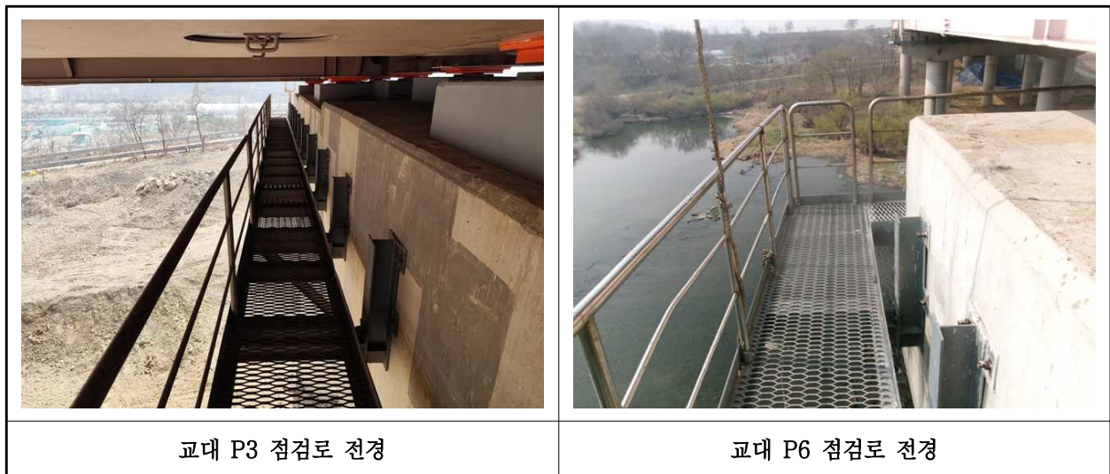
【사진 1.3.52】 교량 점검시설 전경
