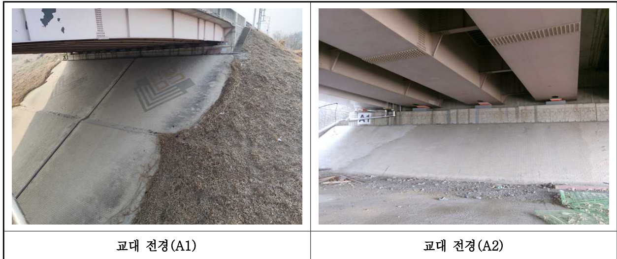
【사진 1.3.8】 교대 전경
