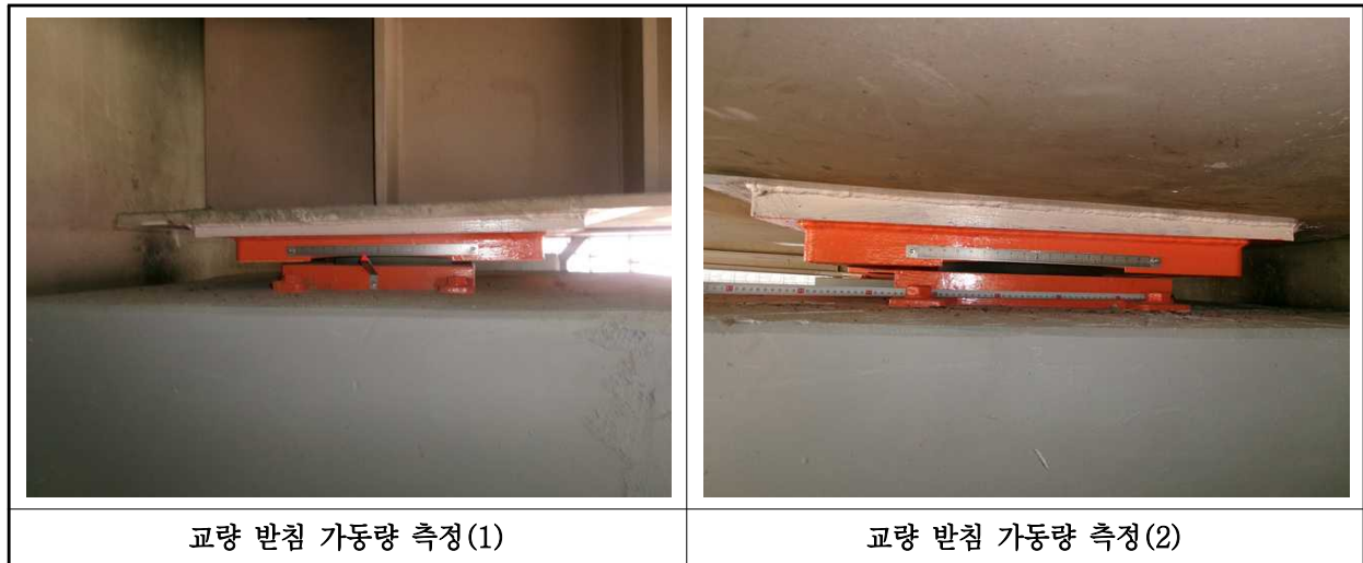
【사진 1.3.42】 교량받침 이동량 측정
