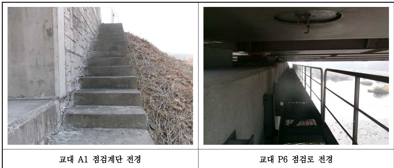
【사진 1.3.25】 교량 점검시설 전경
