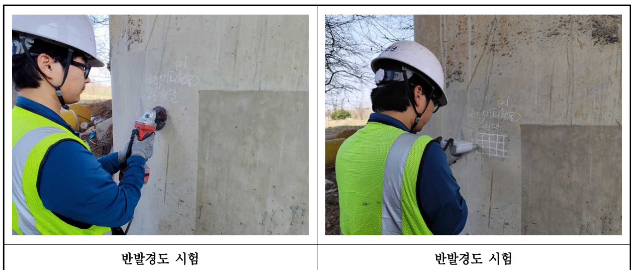
【사진 1.4.2】반발경도시험 현장사진
