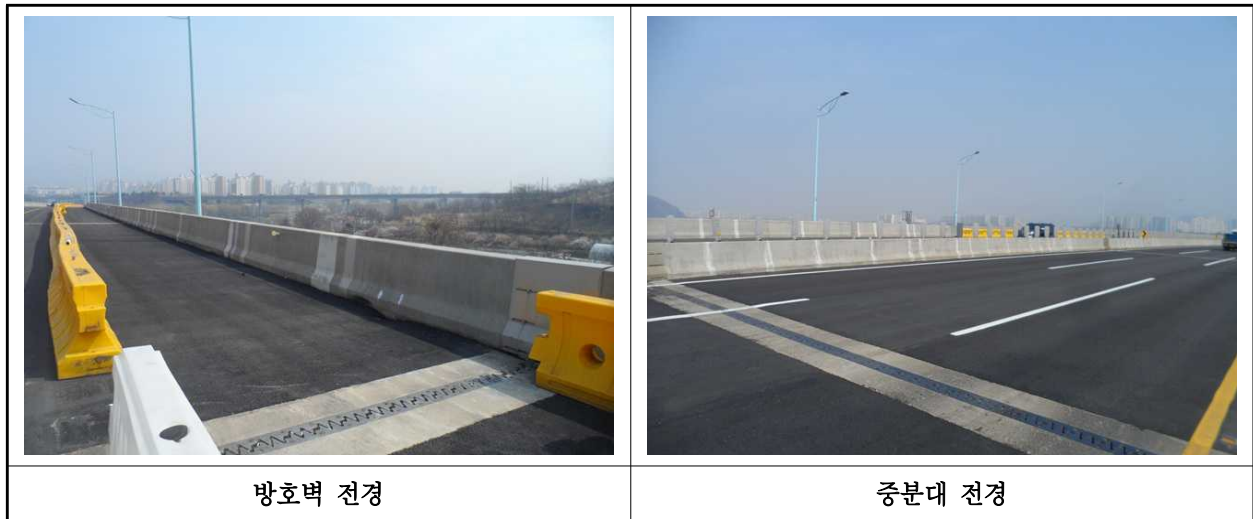
【사진 1.3.50】 방호벽 및 중분대 전경
